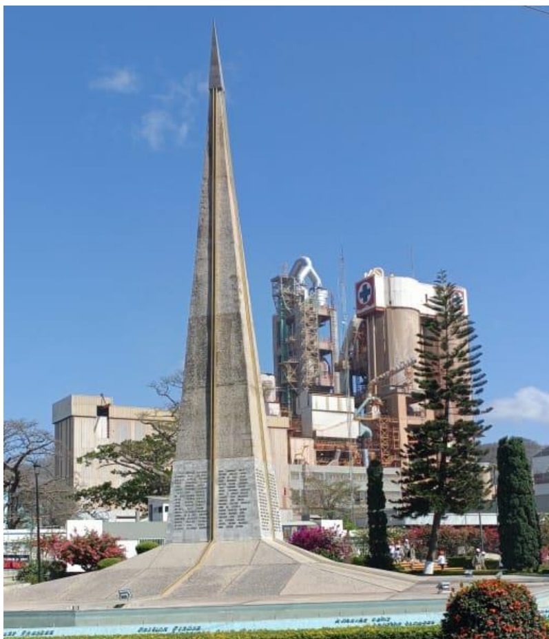
Ilustración 6 Planta de Cemento Cruz Azul en Lagunas, municipio de El Barrio de la Soledad
