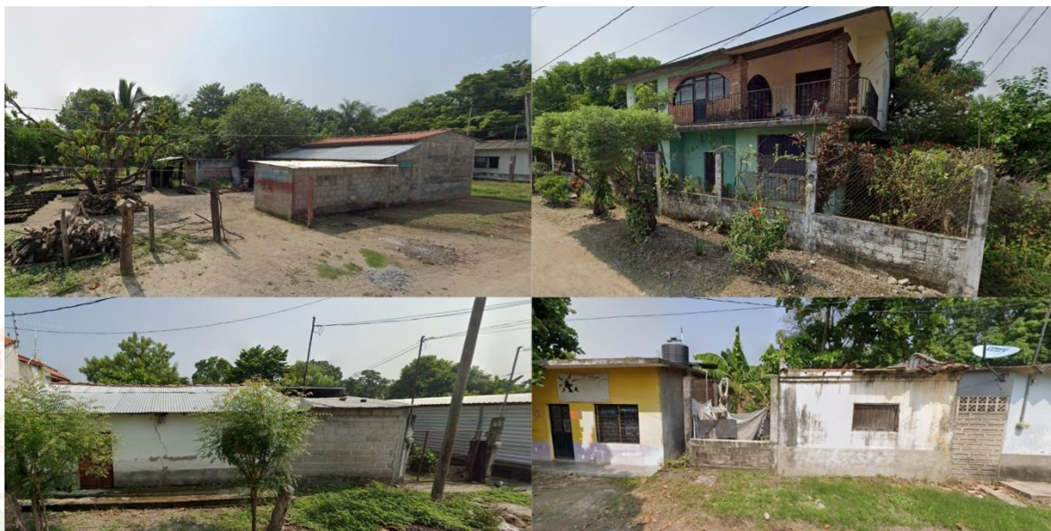
IMAGEN 14. MATERIAL CON QUE SE ENCUENTRAN CONSTRUIDAS LAS VIVIENDAS, CHAHUITES.
