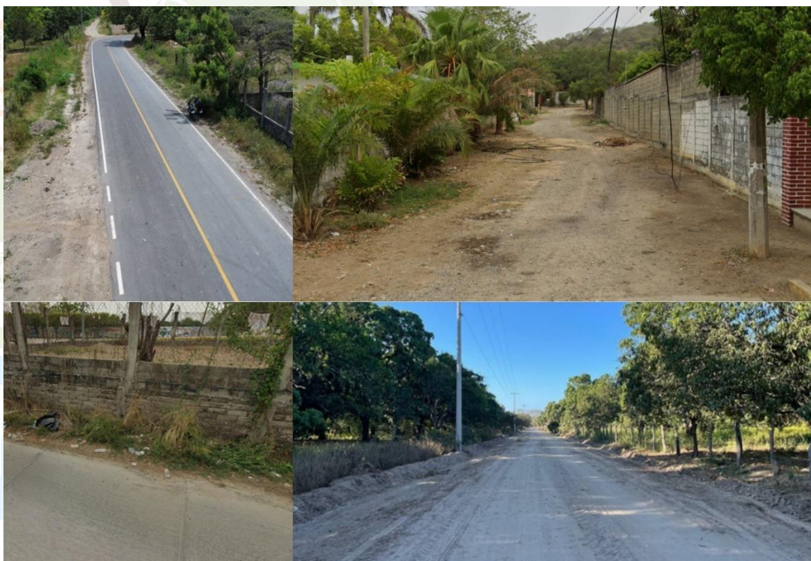
IMAGEN 13. INFRAESTRUCTURA DE CAMINOS Y CARRETERAS, CHAHUITES.
