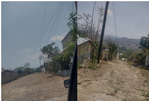
Figura 33.- Calles y Caminos de tierra.
