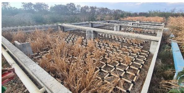
Fotografía 29. Tuberías de PVC en pantanos artificiales
