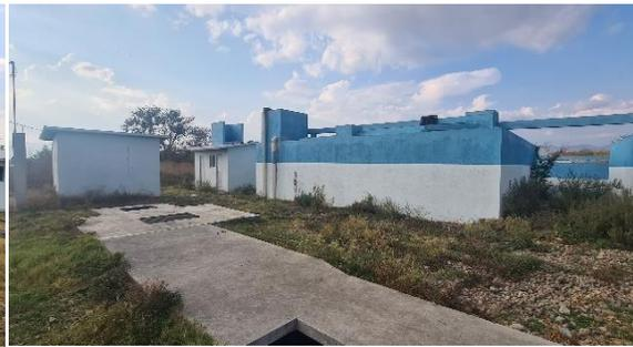
Fotografía 32. Cárcamo de bombeo y caseta de control de bombas de la PTAR
