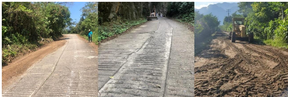
IMAGEN 23. INFRAESTRUCTURA DE CAMINOS Y CARRETERAS.
