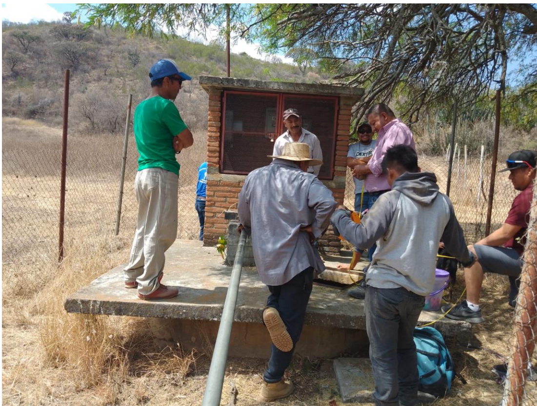
Fotografía del pozo “El Sabino” del barrio El Sabino del municipio de San Jerónimo Silacayoapilla, Huajuapán, Oaxaca.
