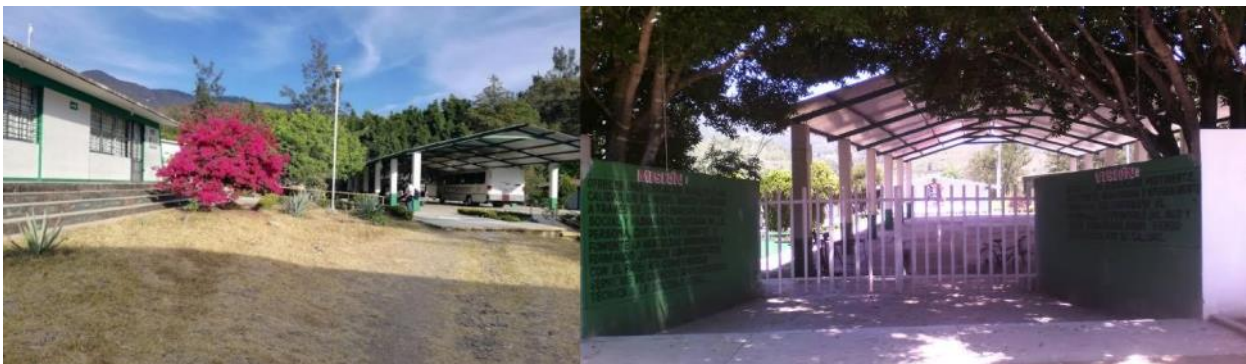
Figura 20. Centro de Bachillerato Tecnológico Agropecuario 201
