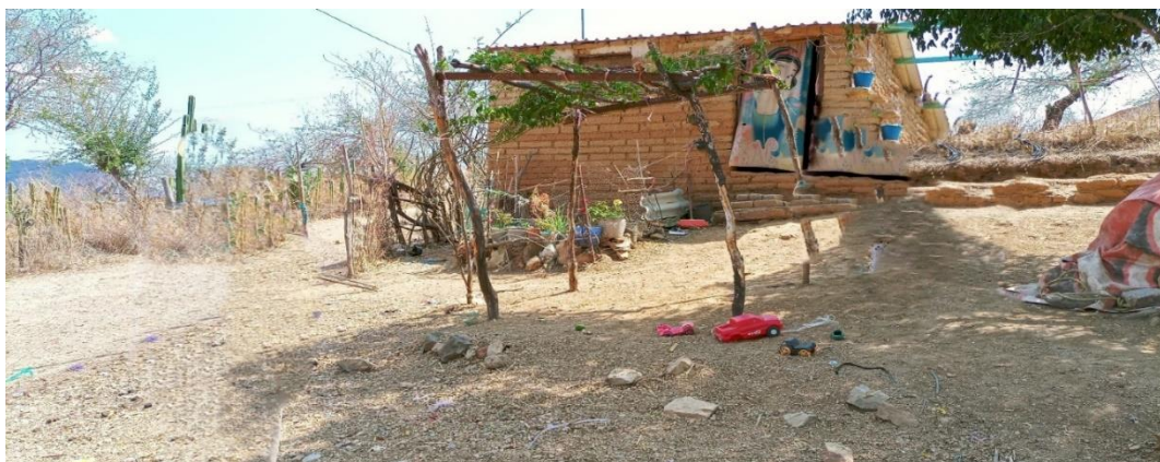
Imagen 18: Viviendas habitadas actuales.
