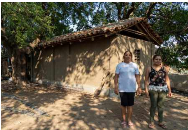
Imagen 6: Imagen de vivienda con piso de tierra, que carece de drenaje en Santo Domingo Tehuantepec.
