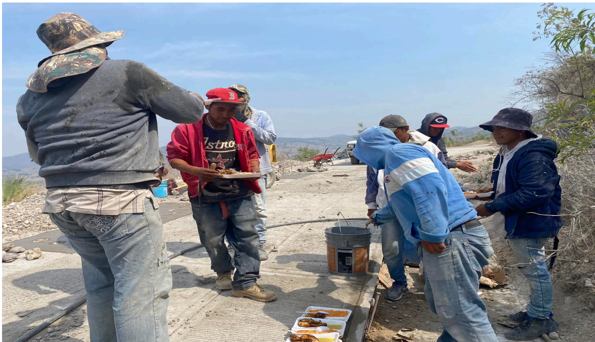
FOTOGRAFÍA. CONSTRUCCIÓN DE CAMINOS EN ZAPOTITLÁN LAGUNAS.
