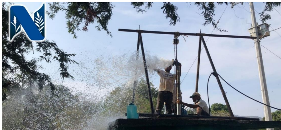
Figura 18. Bombeo de agua en Santiago Niltepec
