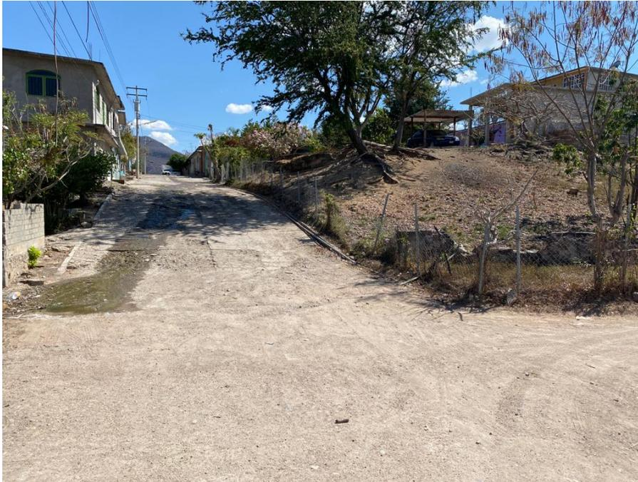
En la presente imagen se puede observar los escurrimientos de aguas derivados de tuberías dañadas de agua potable.
