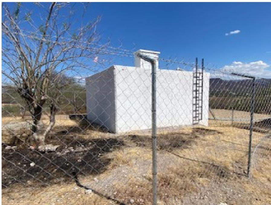
Tanque 2 contenedor de agua potable para distribución, el cual se encontraba vacío al momento de la inspección, este tanque es de reciente creación lo cual podría explicar la falta de funcionamiento.
