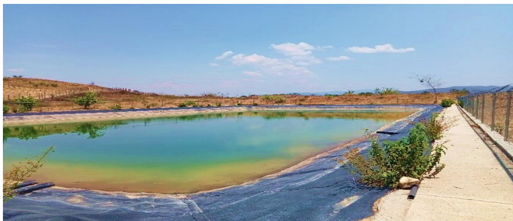
Fotografía 4. Olla de captación de agua en el Municipio
