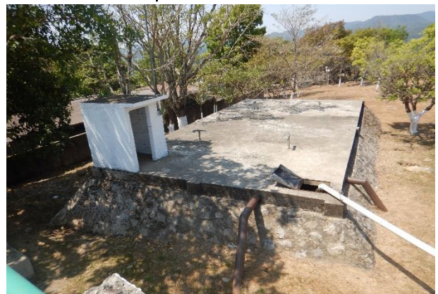
Fotografía 10. Tanque de Mampostería Los Papalotes
