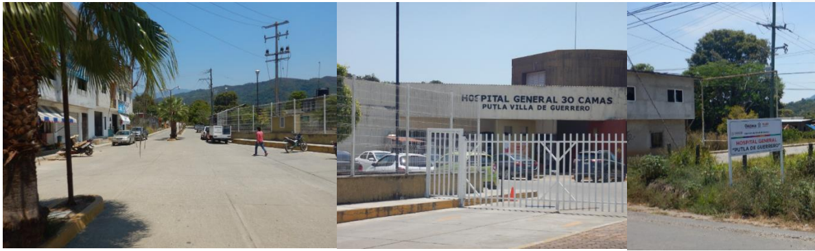
Bloque de fotos 16. Hospital General de 30 camas
