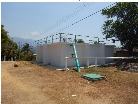
Fotografía 9. Tanque de concreto armado Loma Los Papalotes
