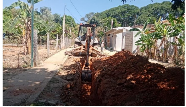
Fotografía 8. Ampliación de agua potable
