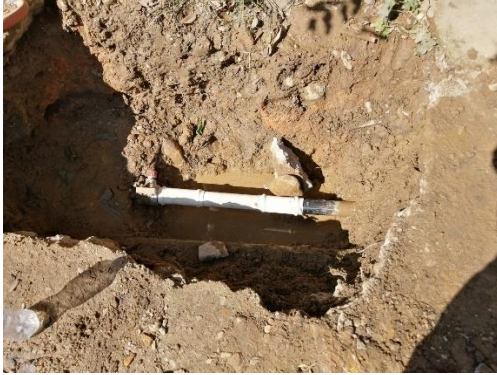
Fotografía 7. Fuga de agua potable en red de 2" PVC
