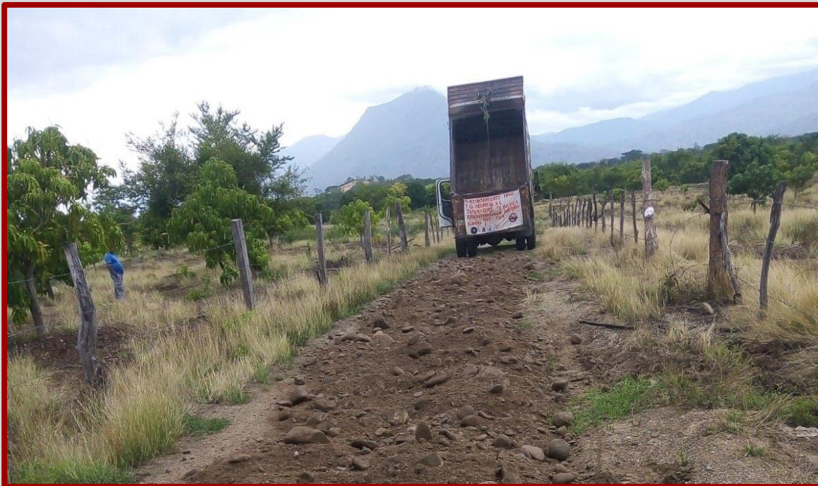
Fotografía 28: Segunda etapa de la rehabilitación del camino cosechero del Ejido los Pirruris
