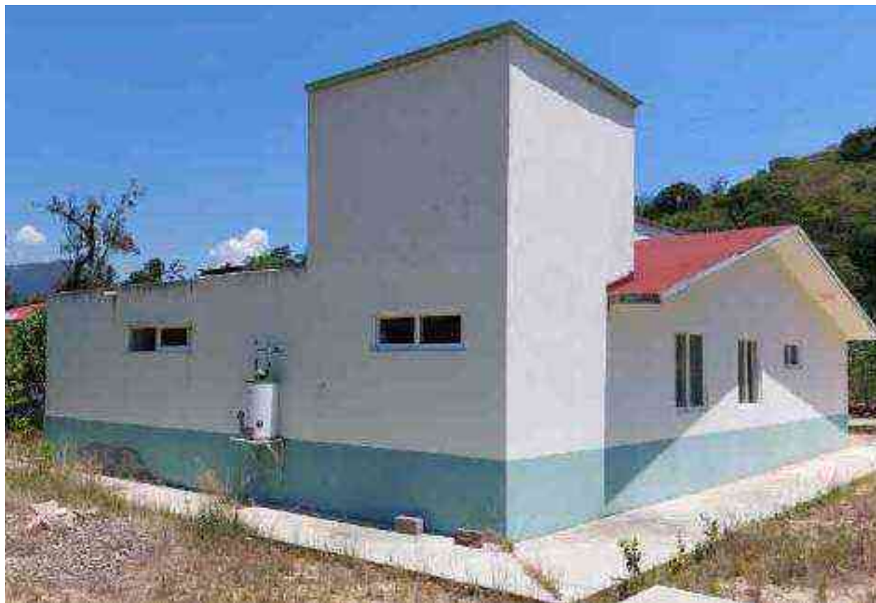
Imagen N.º28: Unidad Médica deshabilitada en San Juan Juquila Mixes. Fuente: Autoría Propia.
