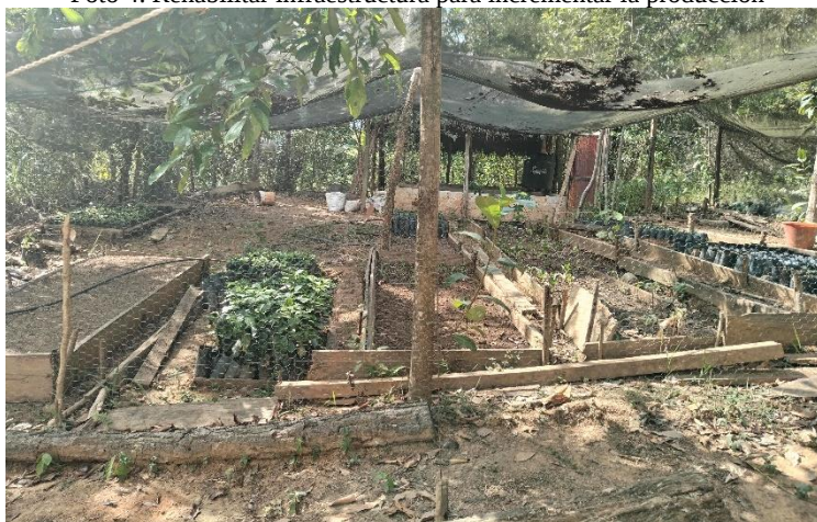
Foto 4. Rehabilitar infraestructura para incrementar la producción
