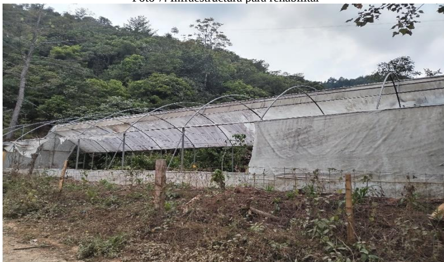
Foto 7. Infraestructura para rehabilitar
