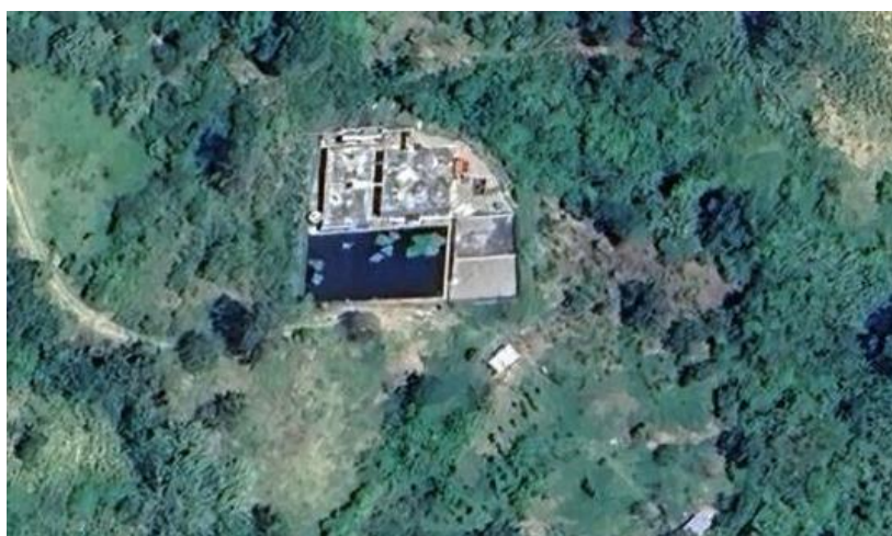
Imagen 5 Planta de Tratamiento de Aguas Residuales, San Pedro Cajonos
