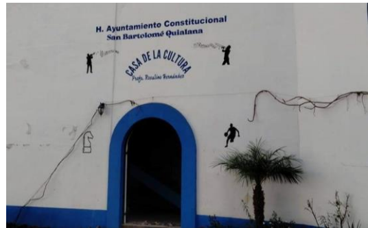
Fotografía 7. Fachada de la Casa de la Cultura.
