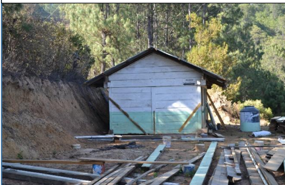
Foto No. 12 Cocina comunitaria de San Esteban Atatlahuca
