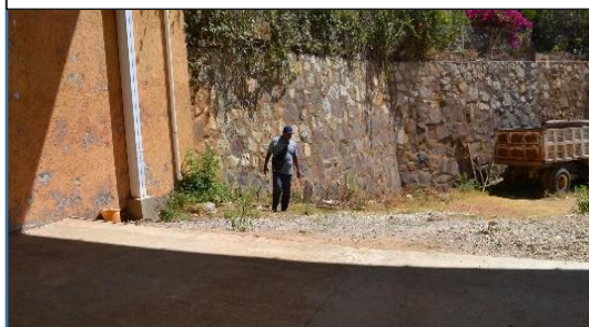
Foto No. 37 Espacio destinado para la construcción de una cisterna
