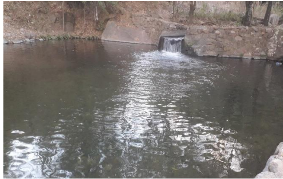
Figura 11. La Presa los Delfines.
