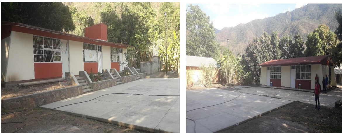
Figura 10. Espacio para la construcción de la cancha de usos múltiples en la telesecundaria.
