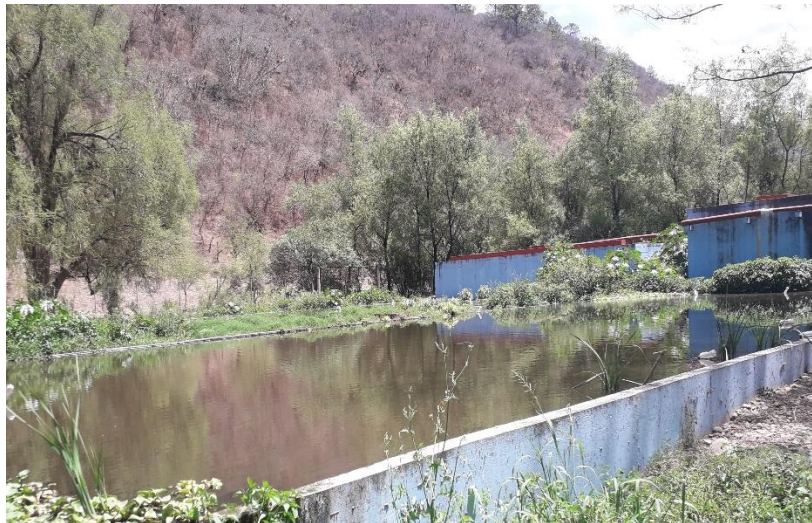
Figura 9. Planta tratadora de aguas residuales.
