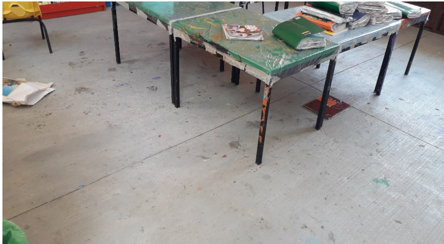
Figura 21. Mejoramiento del piso del salón de preescolar
