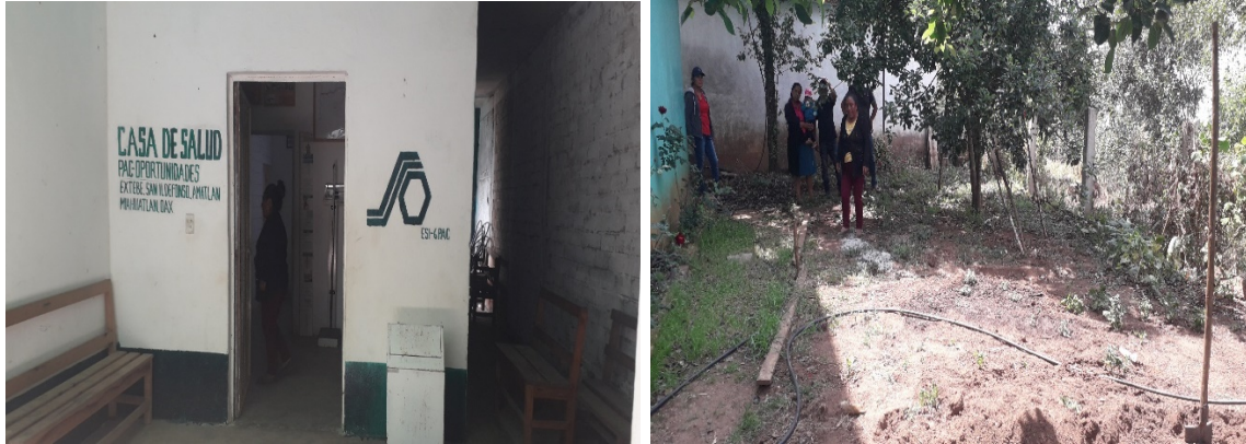
Figura 9. Deficiencia en el cercado perimetral de la casa de salud en Extebé.
