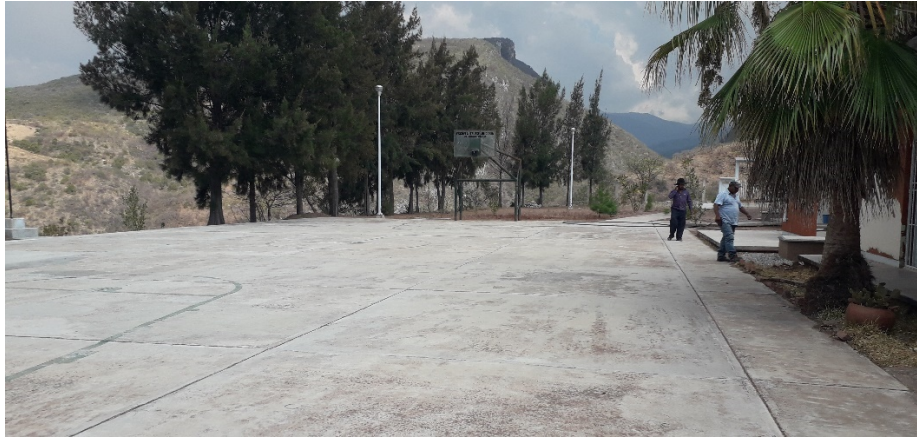
Figura 32. Falta de techado en la cancha de la telesecundaria
