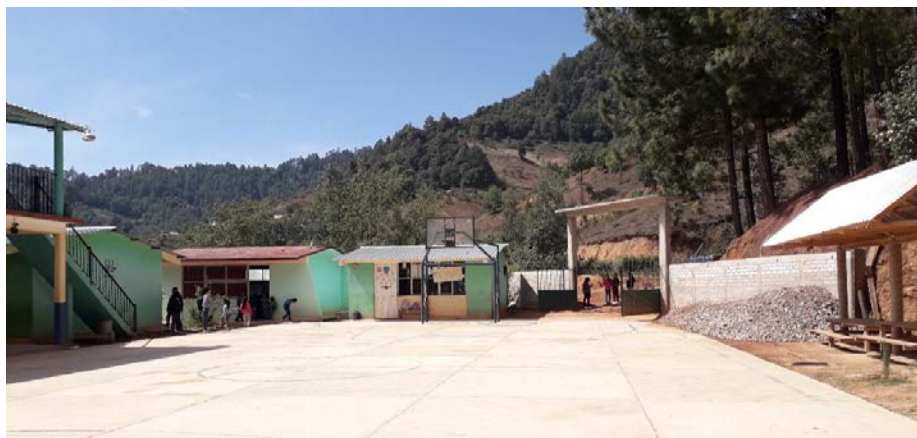
Figura 50. Falta del techado en la cancha de la primaria
