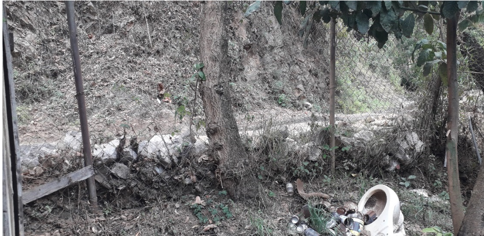
Figura 41. Falta de construcción de la barda perimetral en el preescolar
