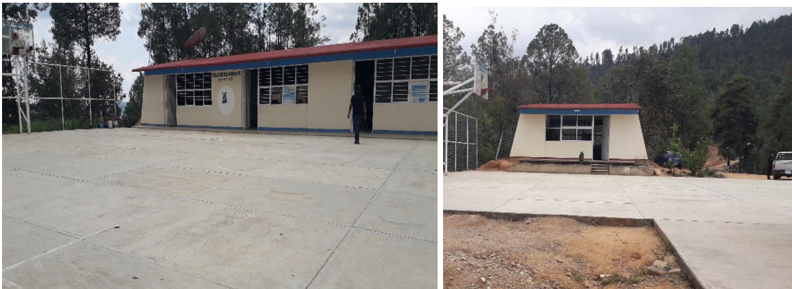
Figura 45. Construcción del techado de la cancha en la Telesecundaria
