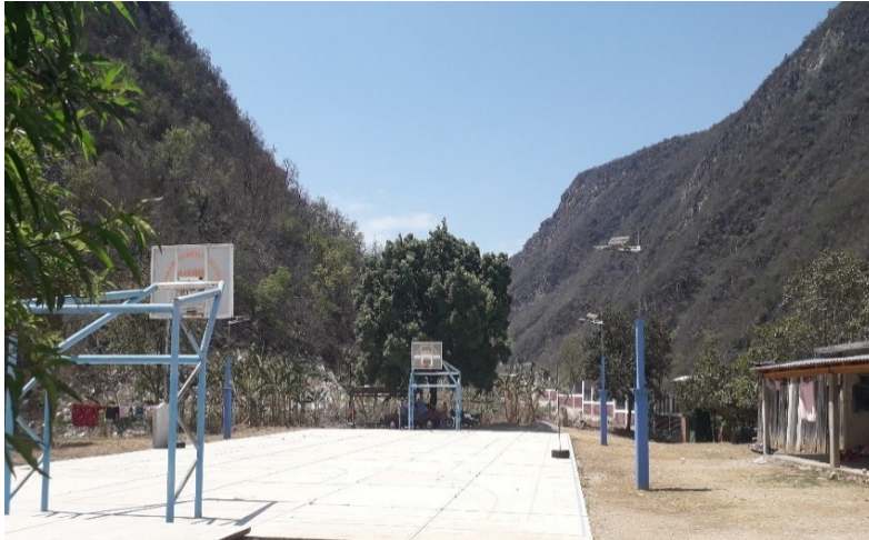
Figura 38. Falta de techado de la cancha de la telesecundaria
