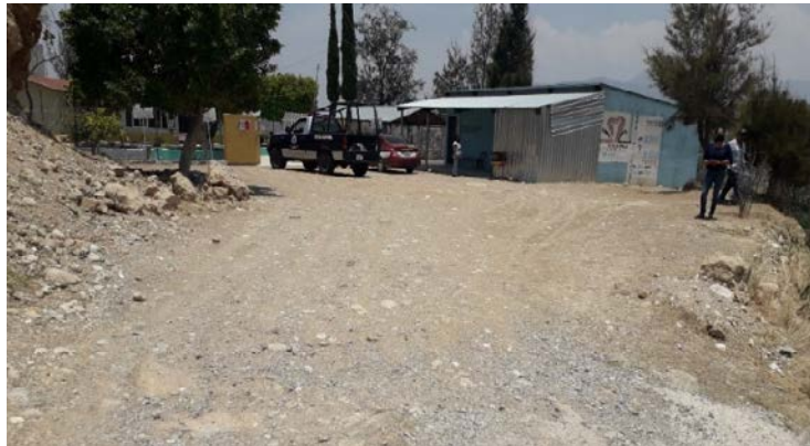
Figura 2. Falta de pavimentación en la entrada principal del centro de salud.
