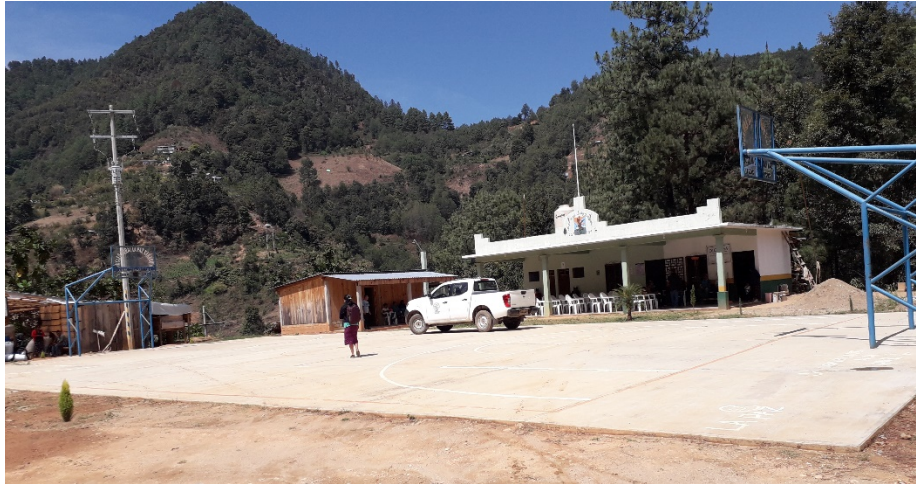
Figura 20. Falta de techado de la cancha en La Paz Xanaguía.
