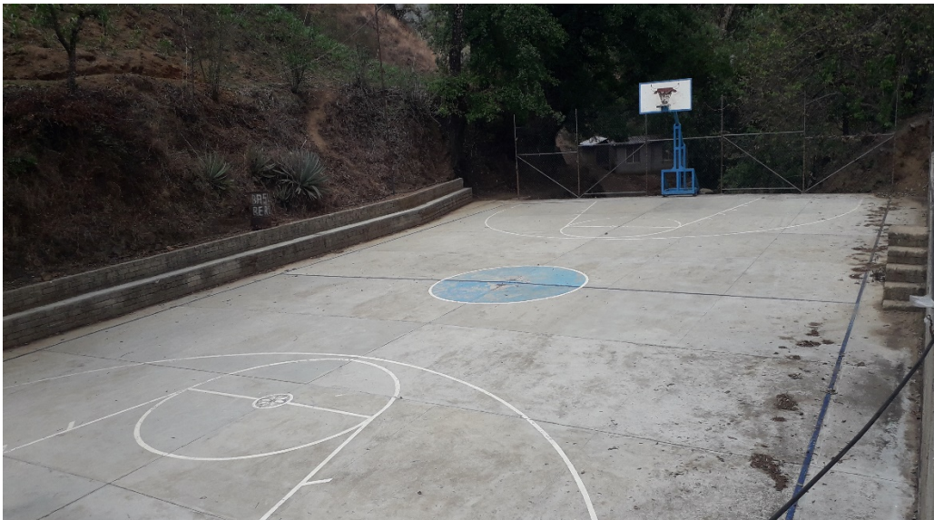
Figura 19. Falta de techado de la cancha en Reforma
