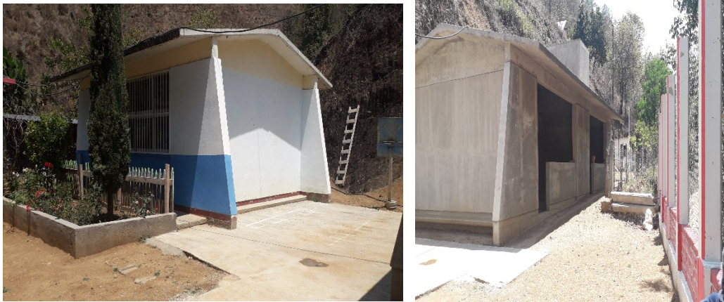
Figura 36. Aula y obra negra en el preescolar
