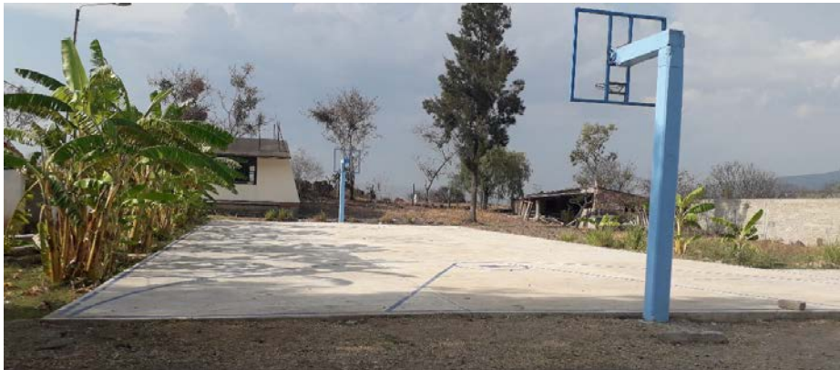
Figura 30. Falta de techado de la cancha de la primaria
