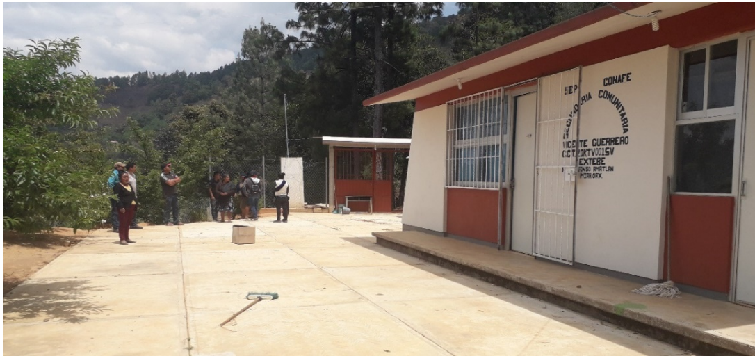
Figura 47. Instalaciones de secundaria Comunitaria
