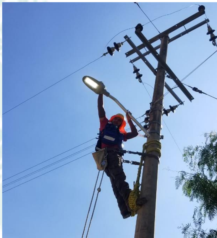
Fotografía N.º 35 Mantenimiento en poste de luz.
