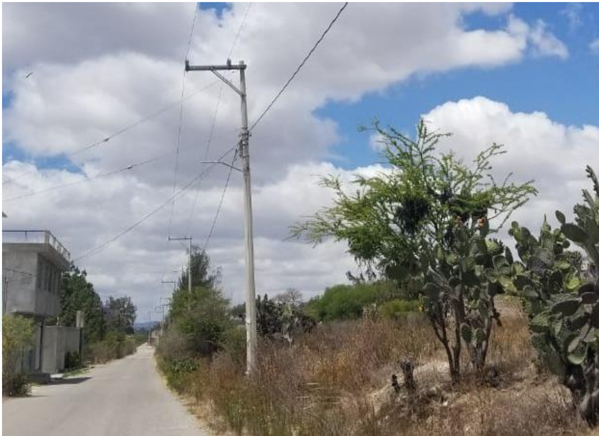
Fotografía N.º 31 Infraestructura en San Juan Bautista Coixtlahuaca.
