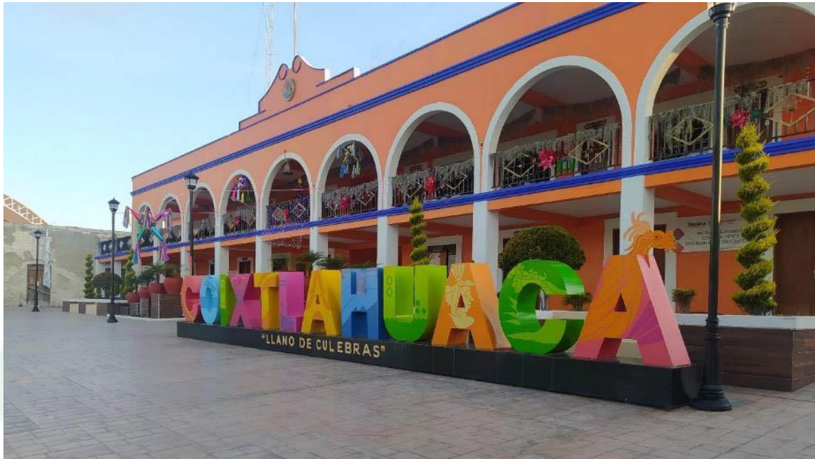
Fotografía N.º 32 Palacio Municipal de San Juan Bautista Coixtlahuaca. Fuente: Autoría Propia.
