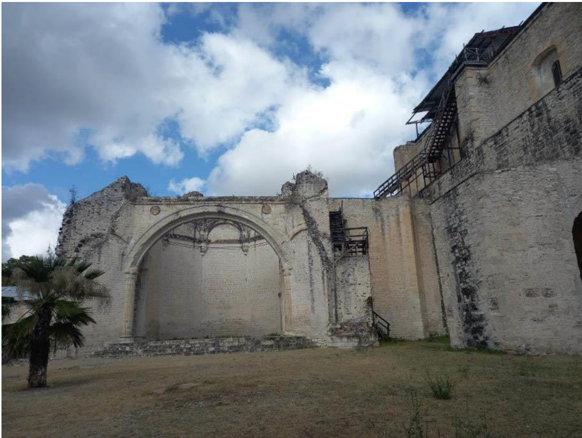
Fotografía N.º 44 Fachada principal de la capilla abierta del siglo XVI. Fuente: Autoría propia.
