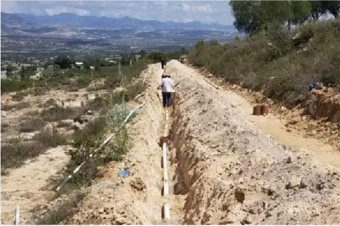
Fotografía N.º 41 Construcción de red de agua potable en San Juan Bautista Coixtlahuaca. Fuente: Autoría Propia.
