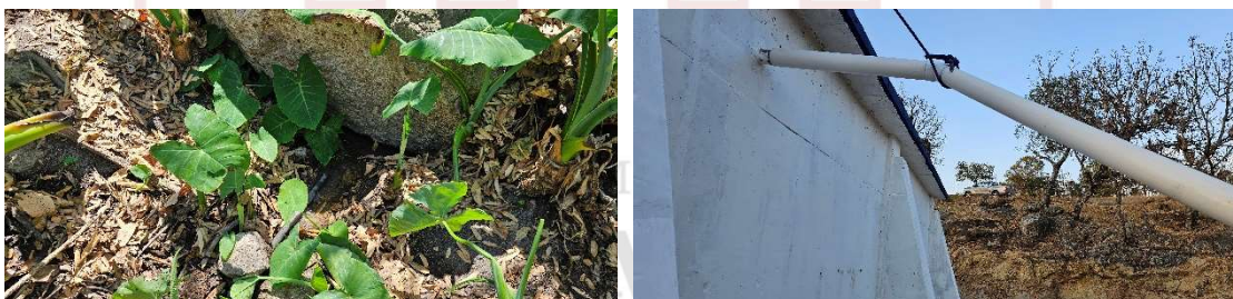
Ilustración 11 Punto de captación y tanque de distribución de agua entubada en la localidad de Yucumí.
