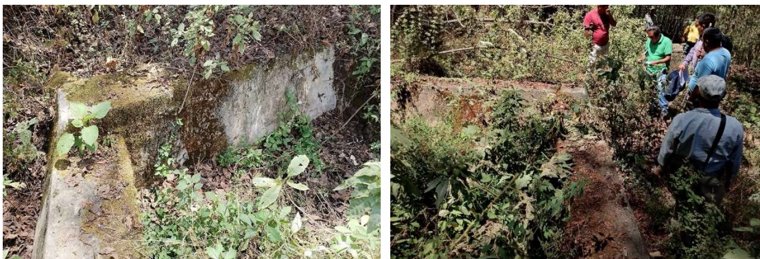
Ilustración 8 Captación de agua existente en la localidad de Santa María Teposlantongo.
