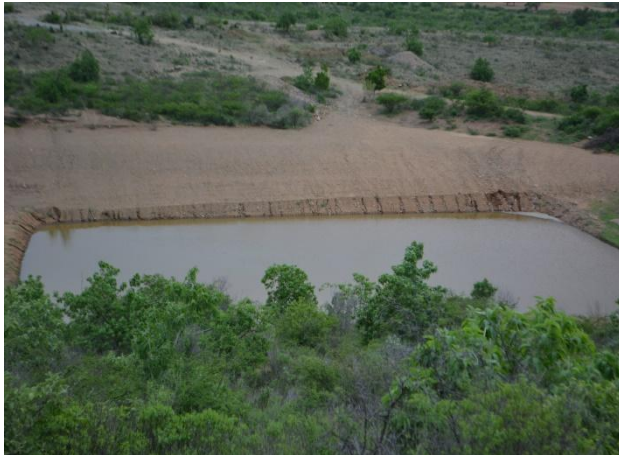
ILUSTRACIÓN 44 , CAPTACIÓN DE AGUAS PLUVIALES EN SAN JUAN TEITIPAC.
