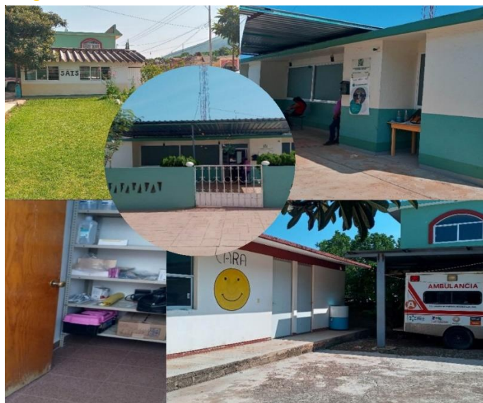
Imagen 3. Infraestructura de salud, San Mateo Sindihui.
