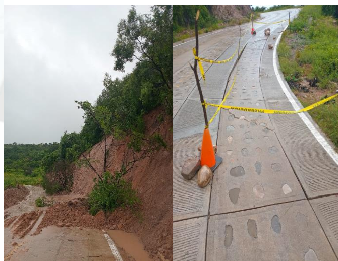
Imagen 11. Infraestructura de carretera, San Mateo Sindihui.
