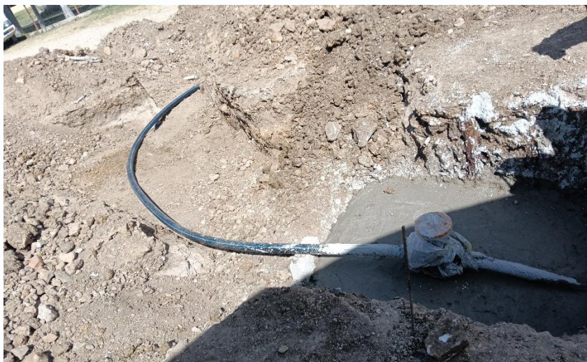
Válvula de sectorización en la localidad de El Fortín Alto
