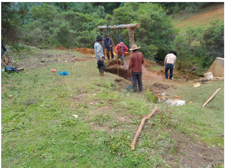
Imagen 13. Construcción de almacenamiento de agua.
