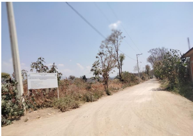
Ilustración 57.- Carretera perteneciente al municipio de San Sebastián Abasolo. Año 2023
