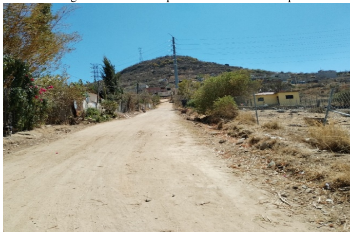
Imagen No. 8. Calle sin pavimentación del municipio
