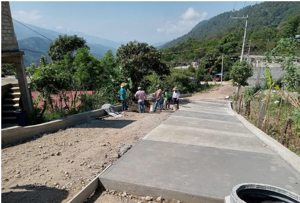
Pavimentación de la calle Reforma
