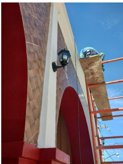
Rehabilitación del palacio municipal
