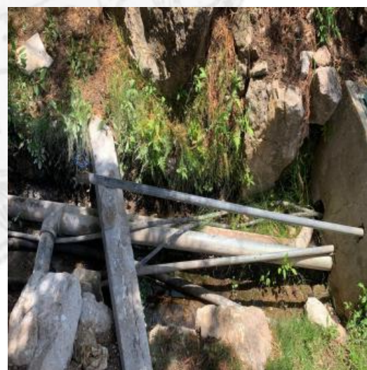
IMAGEN 25. INFRAESTRUCTURA DE AGUA ENTUBADA.
