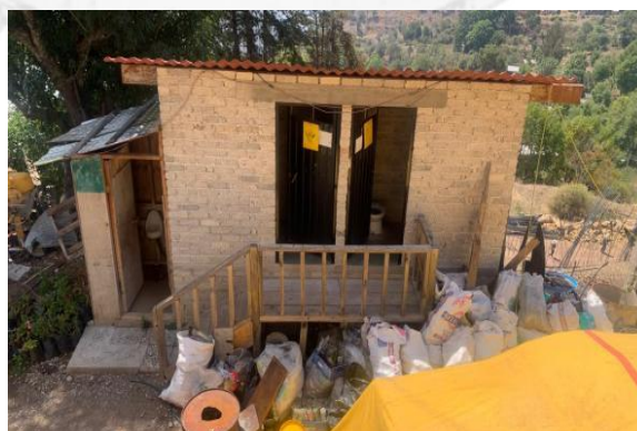
IMAGEN 26. SANITARIOS EN SANTO DOMINGO IXCATLÁN.
