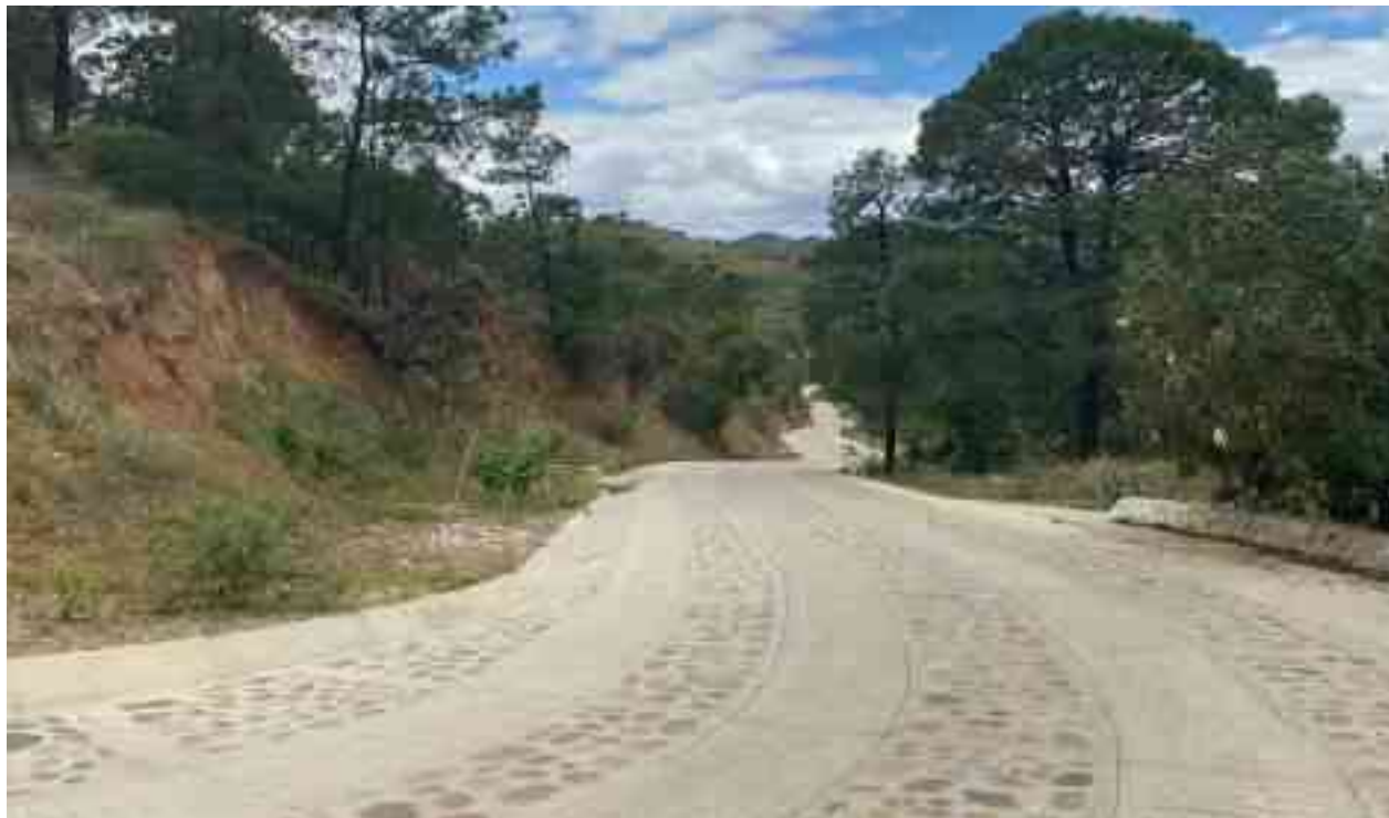
Imagen N.º63: Carretera para acceso al Municipio de Santo Domingo Nuxaá. Fuente: Autoría propia.
