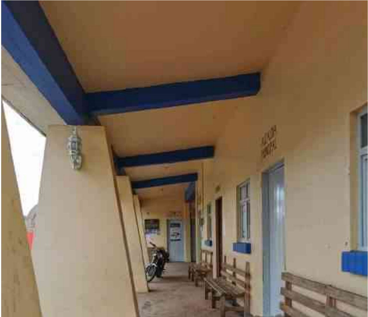
Imagen N.º33: Oficinas para atención de habitantes de Santo Domingo Nuxaá. Fuente: Autoría Propia.
