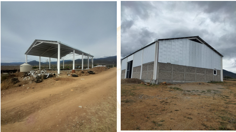
Figura 51. Construcción del centro para la gestión integral de residuos sólidos
