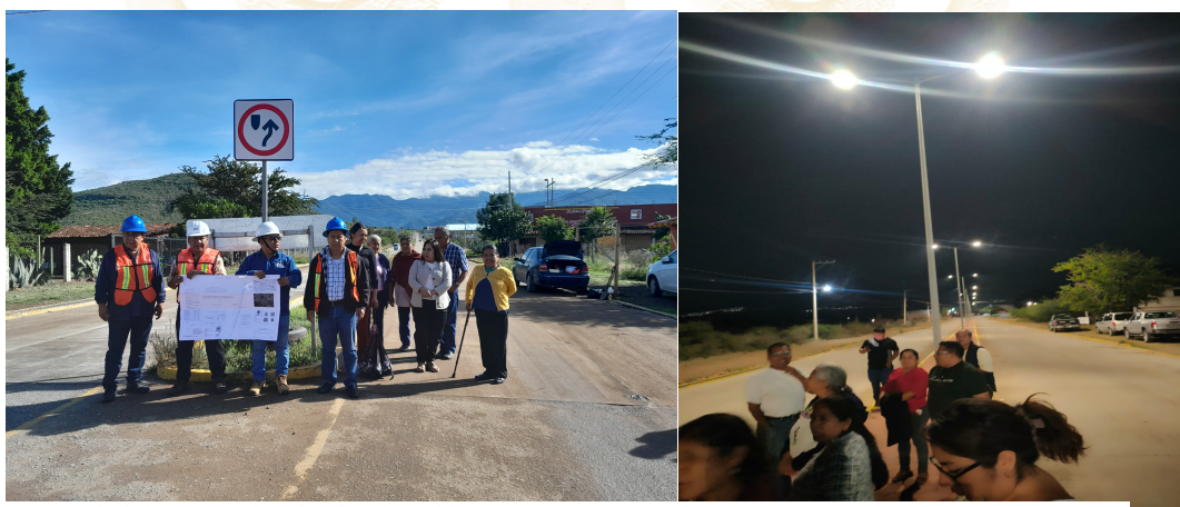
Figura 50. Rehabilitación del alumbrado público en AV. Juárez
