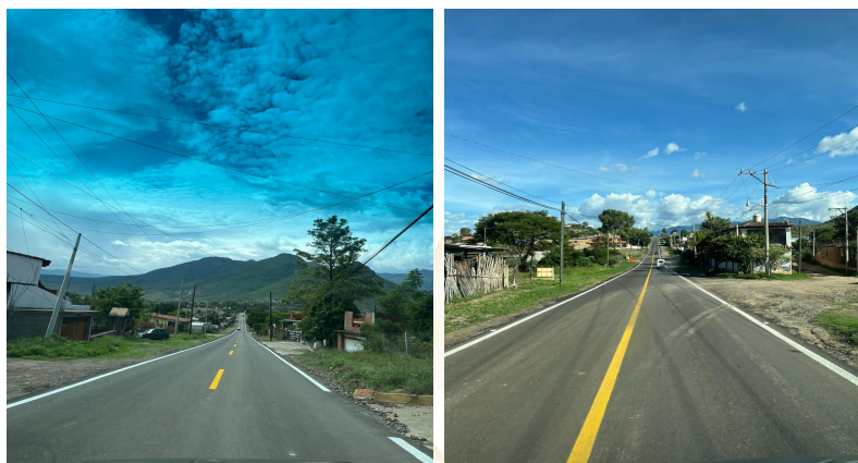
Figura 53. La carretera de acceso a Teotitlán del Valle rehabilitada.
