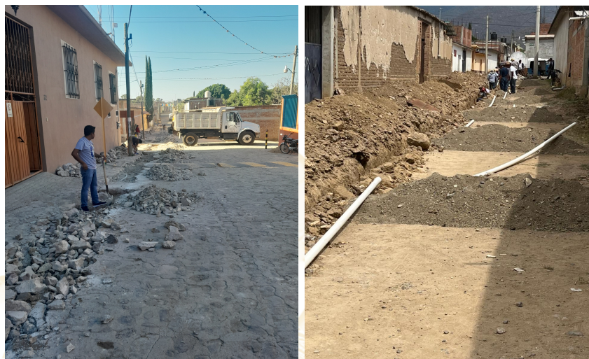
Figura 59. Reemplazo de la tubería de asbesto por tubería de PVC.
