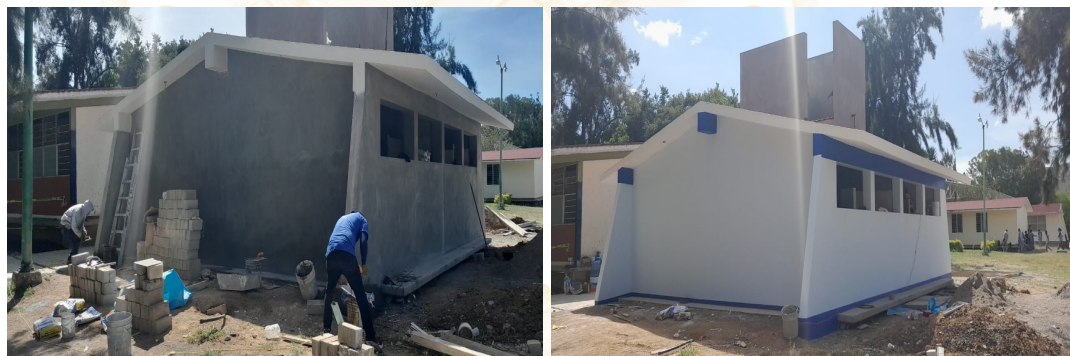
Figura 61.Rehabilitación de los baños de la escuela Secundaria “Agustín Melgar”
