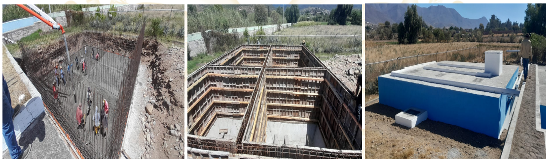
Figura 60. Proceso de construcción del biodigestor en la planta tratadora de aguas residuales.
