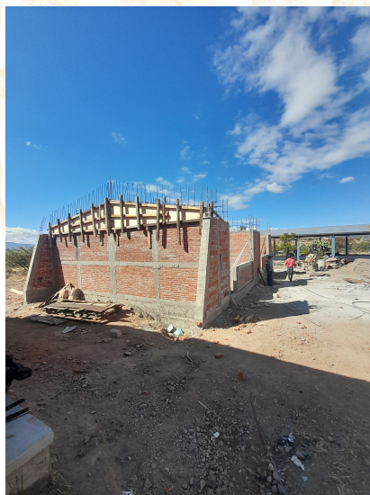
Figura 62.Construcción de 2 aulas en el BIC 29
