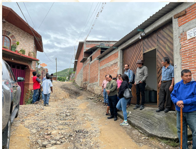
Figura 56. Calle Emiliano Zapata en malas condiciones.
