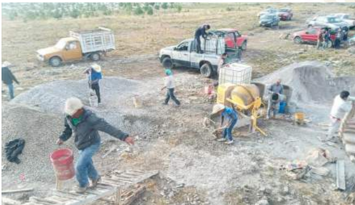
Fotografía N° 59 Construcción y rehabilitación de sistema de agua potable en Tepelmeme Villa de Morelos.
