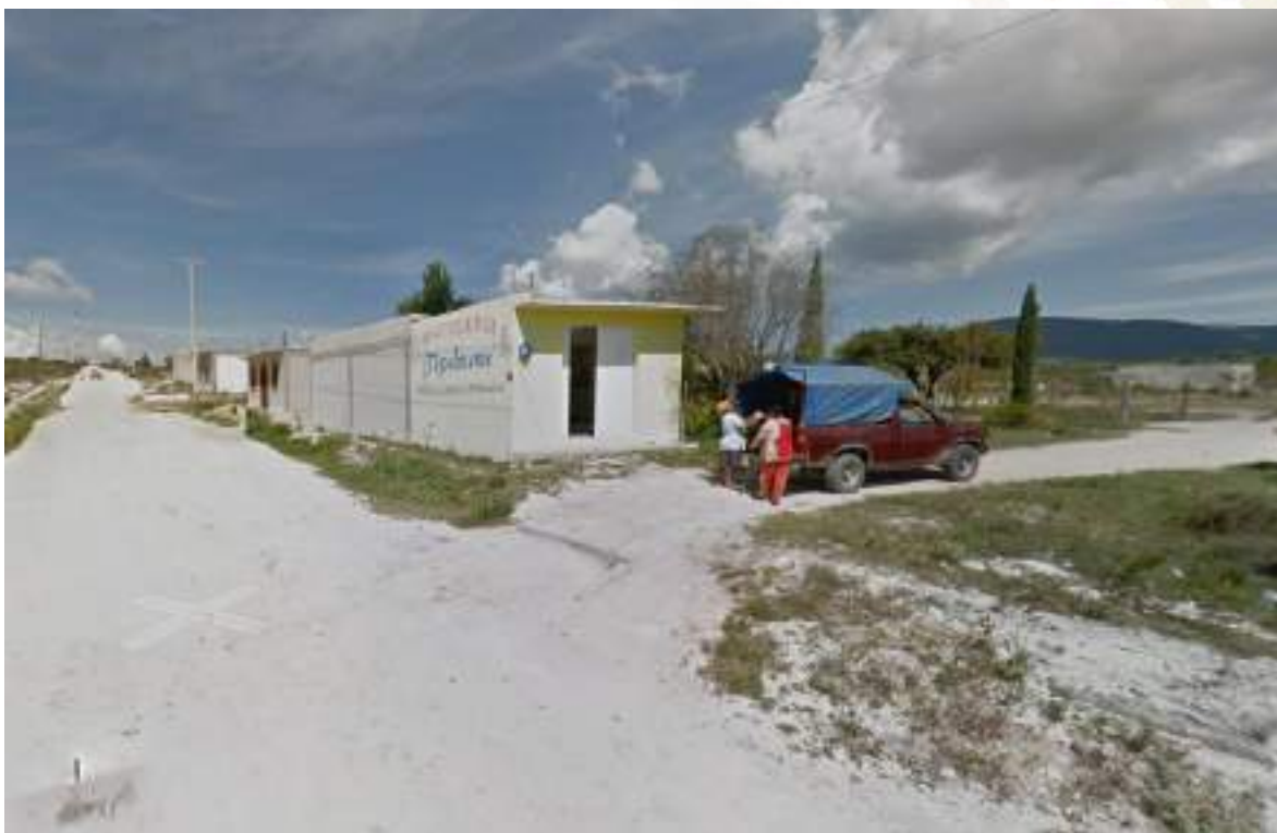
Fotografía N° 77 Camino de terracerías en cruce, se aprecia tubería de desagüe pluvial expuesto.
