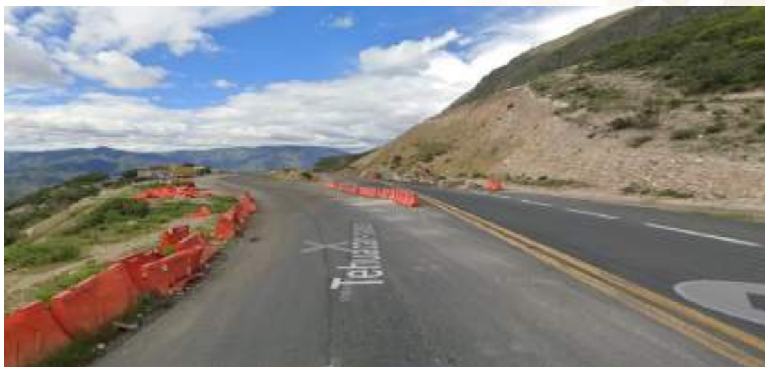
Fotografía N° 78 Tramo en reparación 103+000.00 al 102+800.00 dirección Oaxaca a Cuacnopalan.
