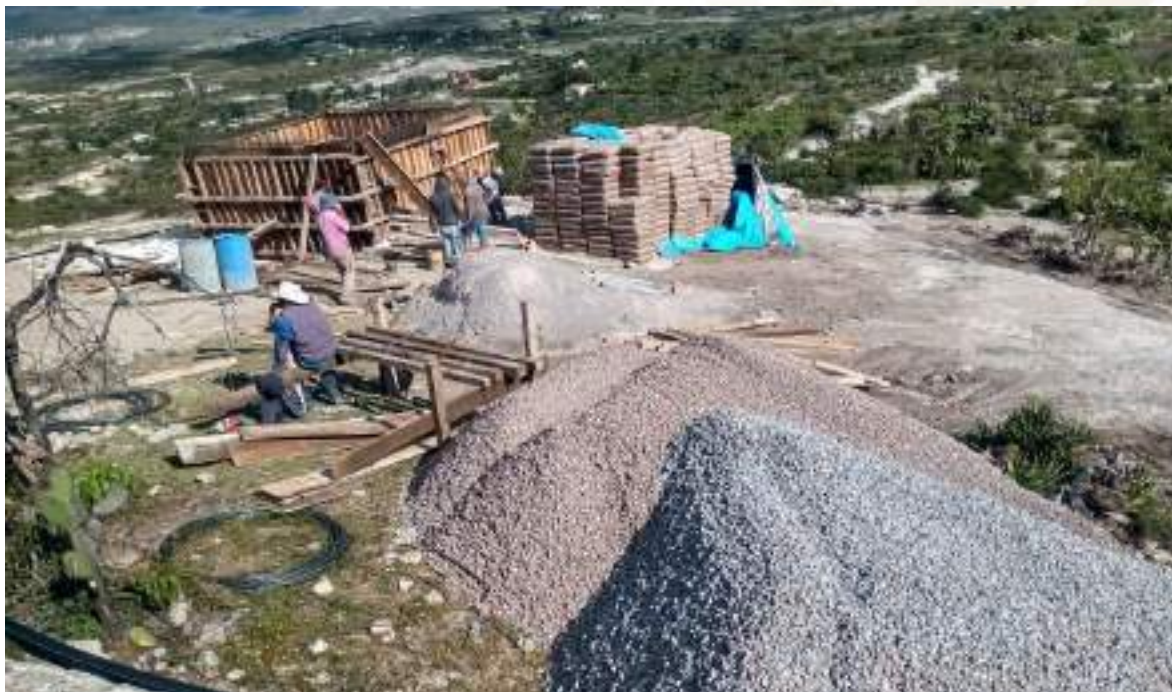
Fotografía N.º 43 Rehabilitación de sistema de agua potable en Tepelmeme Villa de Morelos. Fuente: (Facebook, 2024)
