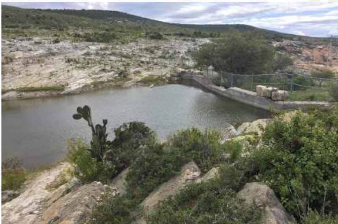
Fotografía N° 65 Presa y su ecosistema en Tepelmeme Villa de Morelos.
