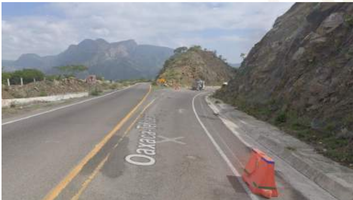
Fotografía N° 79 Tramo Km 96+400.00 dirección Oaxaca a Cuacnopalan.
