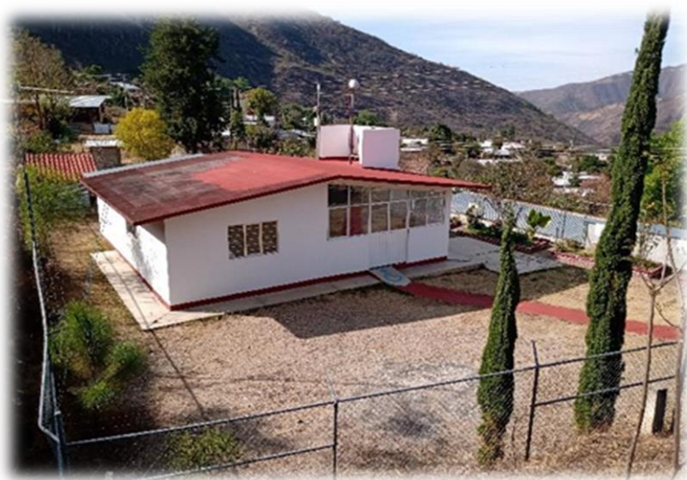
Fuente: Casa de salud en el Municipio de San Miguel del Río
