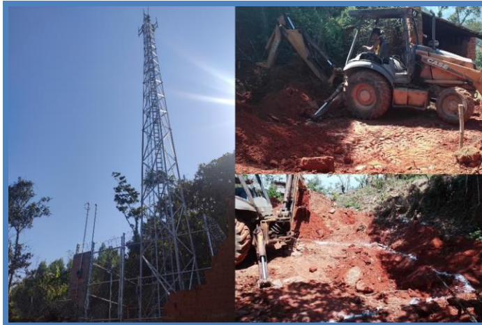
Imagen 21. Trabajos para la instalación de la antena.
