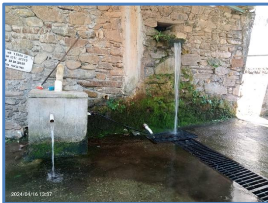
Imagen 04. Tanque receptor de agua.
