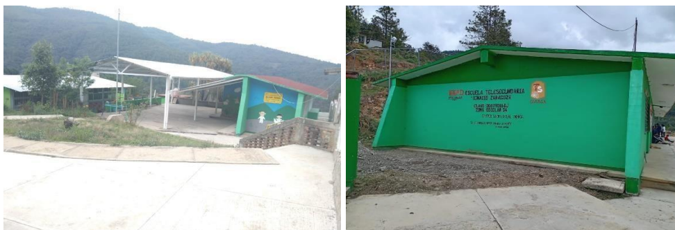
Infraestructura de las escuelas de educación básica del municipio de Santiago Laxopa y sus dos agencias
