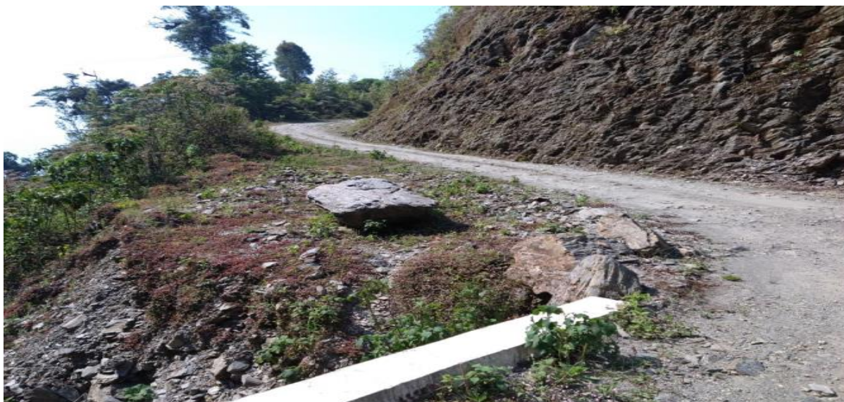
Camino en mal estado hacia la agencia de Santa María Tonaguía.
