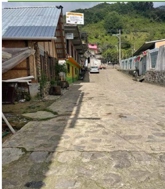
Calles empedradas en la Cabecera Municipal.
