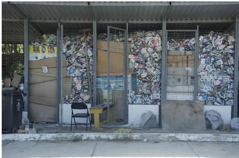
Foto: Espacio designado para los residuos sólidos.
