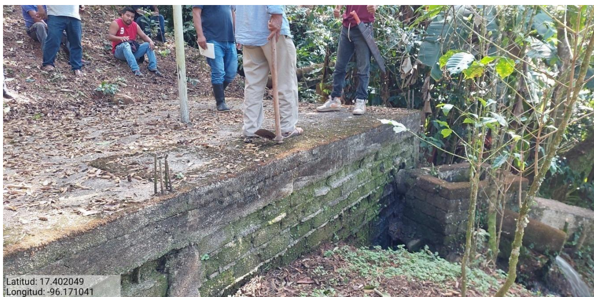
Imagen 18 Fosa séptica para saneamiento de agua.
