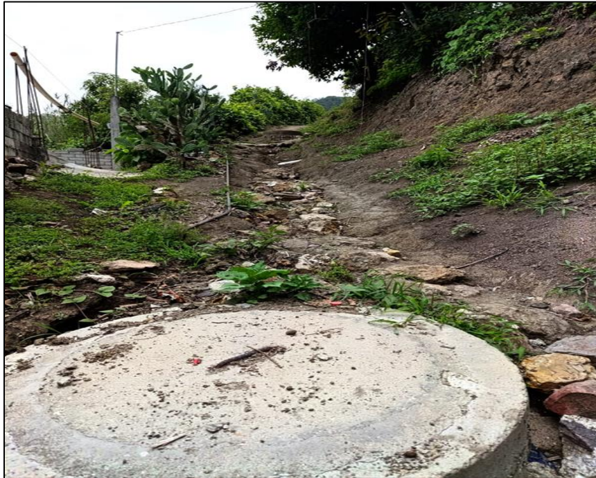
Figura 6.28 Tramos de drenaje en mal estado en San Pablo Yaganiza.
