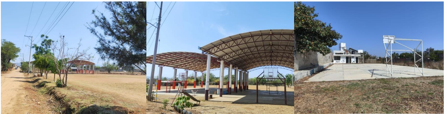
Instalaciones deportivas, Cuilápam de Guerrero
