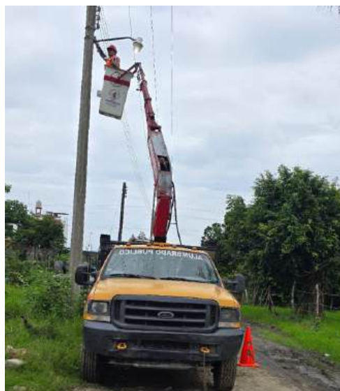
Cambio de luminaria en el servicio de alumbrado público
