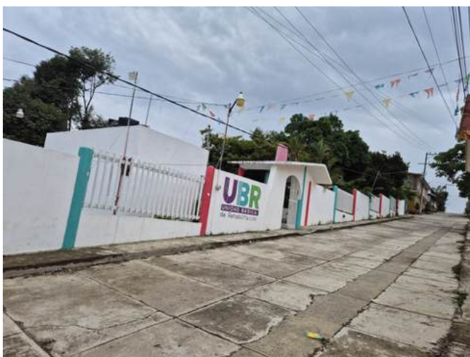
Vista externa de las instalaciones de la UBR en Putla.
