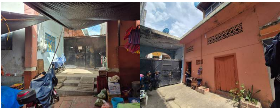
Vista exterior e interior de la comandancia de policía de la localidad de Putla Villa de Guerrero
