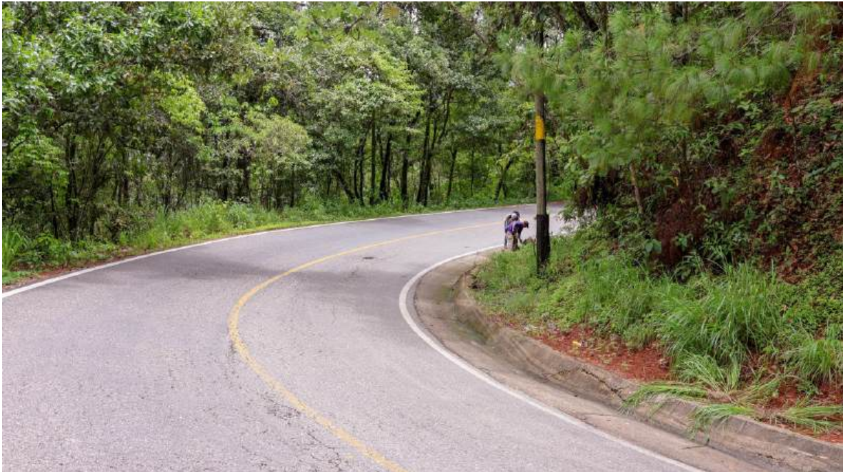
Tramo carretero que conecta a la comunidad de Putla con otras comunidades.
