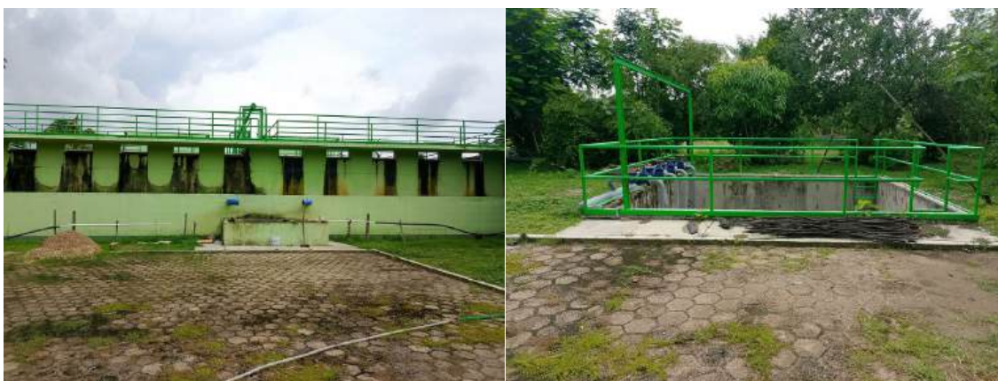
Planta de Tratamiento de Aguas Residuales en Putla Villa de Guerrero
