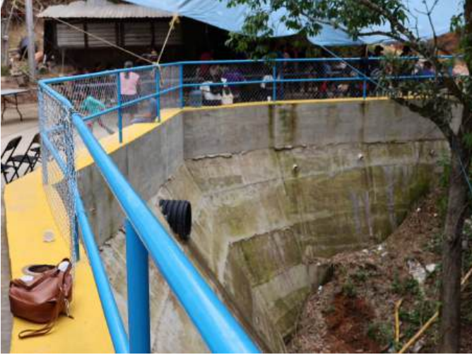
Muestra de la elaboración de un muro de contención para garantizar el seguro paso peatonal de los habitantes.
