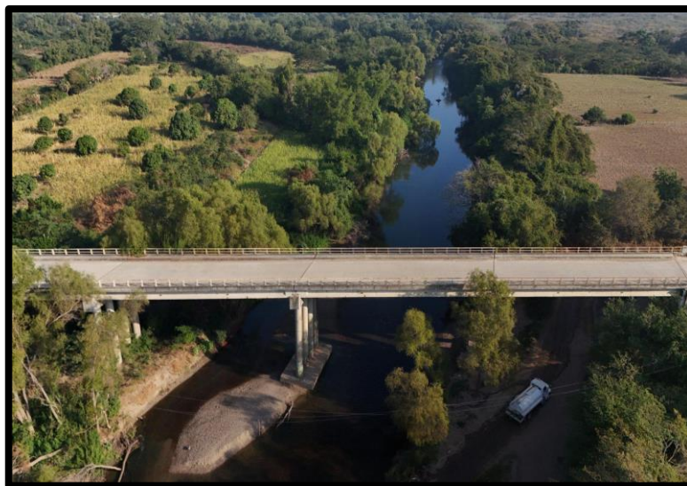
Figura No.7. Puente río Ostuta de Reforma de Pineda.
