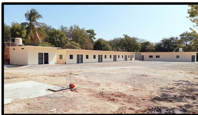
Figura No.12. Edificio donde se ubica la casa de la cultura.
