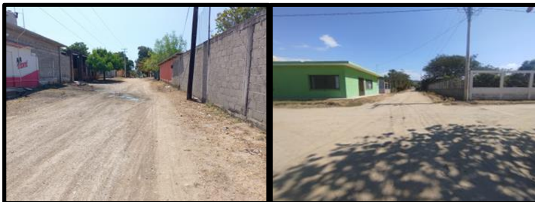
Figura No. 23. Caminos no pavimentados.
