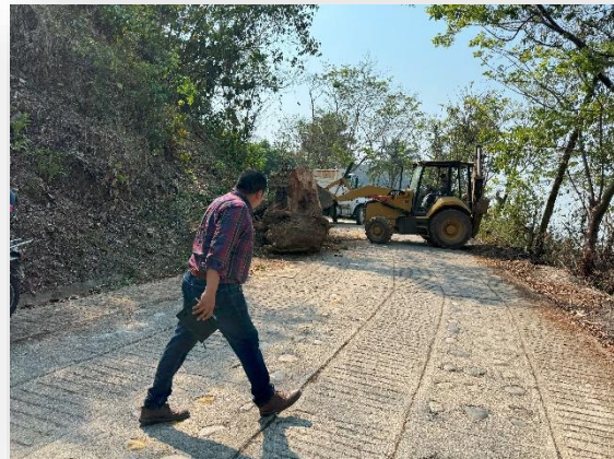
San José Independencia, Tuxtepec. 14 (Carreteras, fuente propia)
