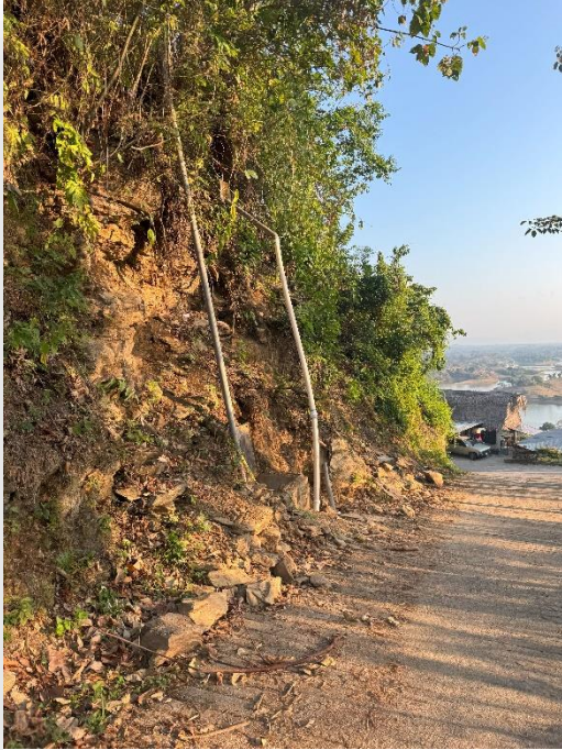
San José Independencia, Tuxtepec. 20 (Agua Potable, fuente propia)
