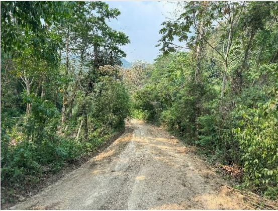
San José Independencia, Tuxtepec. 16 (Carreteras, fuente propia)
