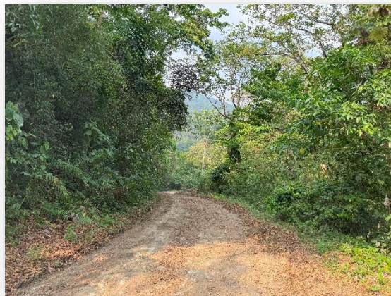
San José Independencia, Tuxtepec. 18 (Carreteras, fuente propia)
