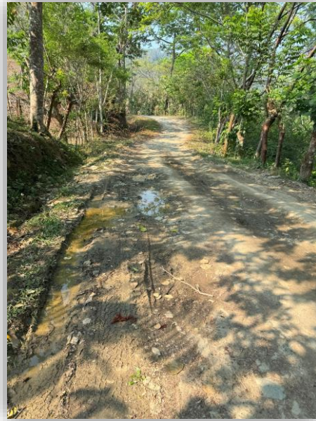
San José Independencia, Tuxtepec. 12(Carreteras, fuente propia)
