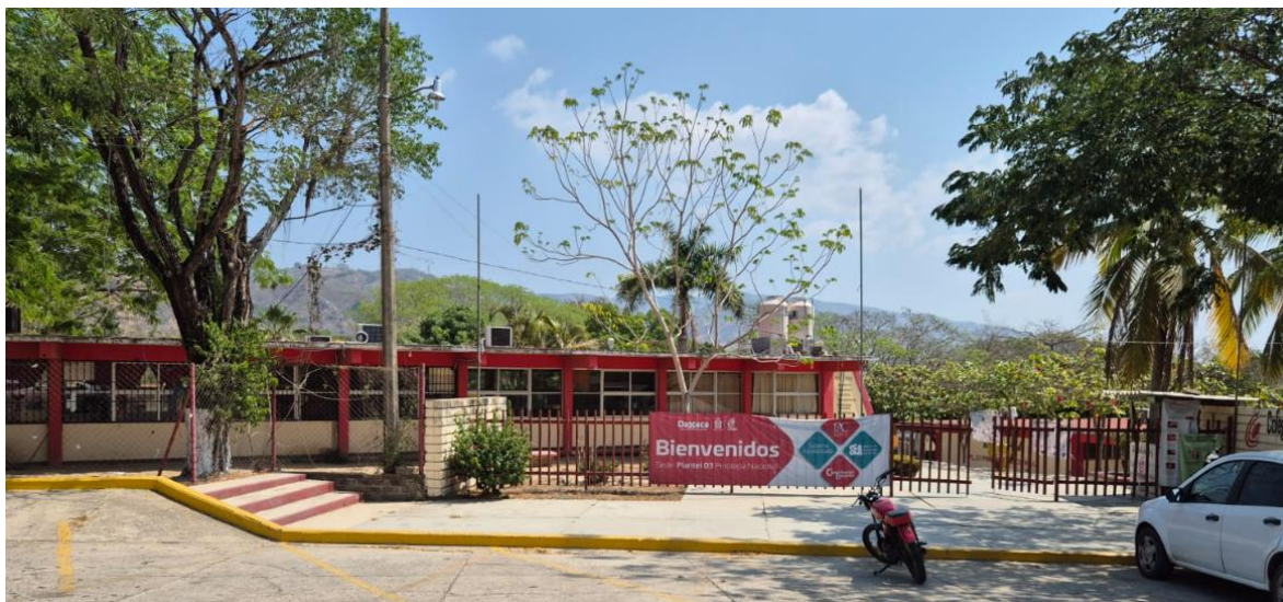
Fotografía de las instalaciones del COBAO
