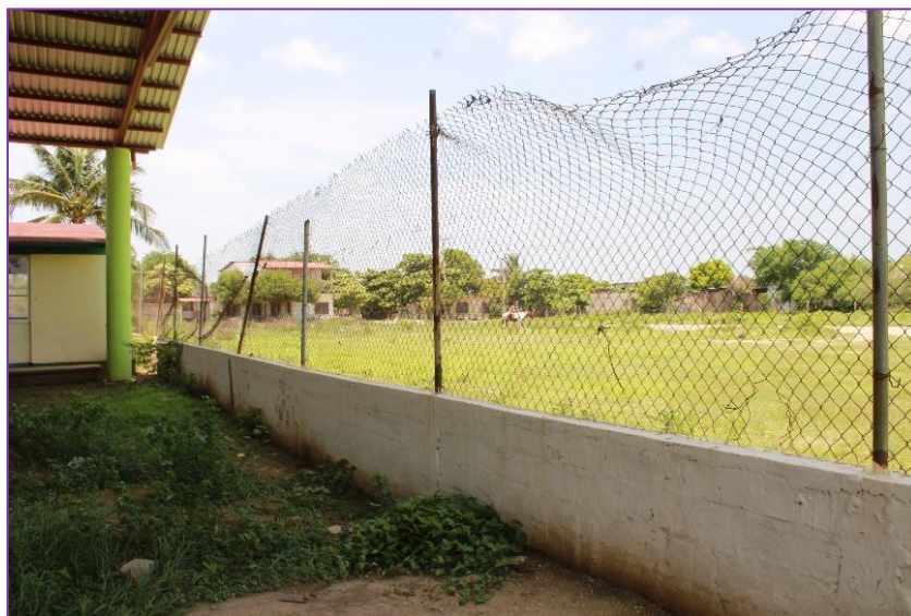
Fotografía perímetro de la escuela Nemesio C. Remetería
